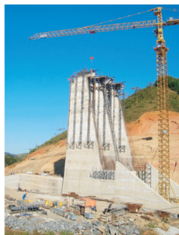
Figura 7 – PCH Santa Fé – Lançamento do Concreto com Bica Corrida (BC1) na Tomada D'água.
