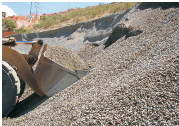
Figura 3 – PCH Santa Fé – Carregamento de BC1 para a produção do concreto.
