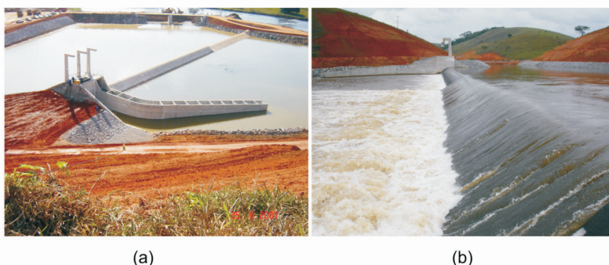
Figura 1 – PCH Santa Fé – Barragem submersa: (a) durante a construção, (b) em operação. A seta indica o local de descontinuidade do barramento, possibilitando a continuidade da prática de esportes, tais como rafting e canoagem.
