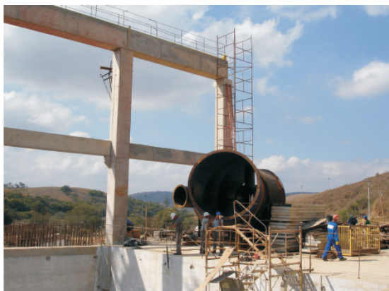
Figura 8 – PCH Santa Fé – Pré-moldados da Casa de Força que utilizaram Brita Corrida (BCI).
