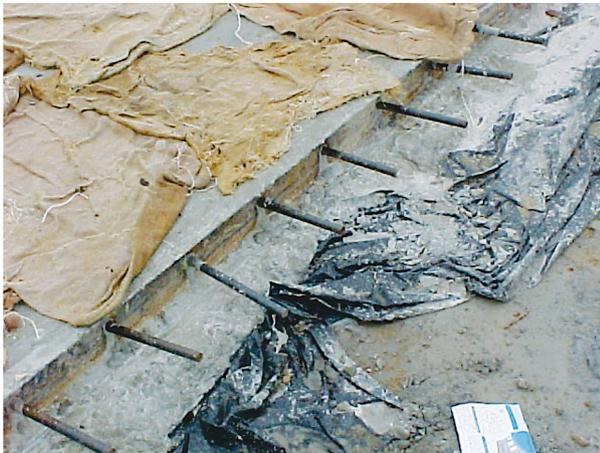
**Figura 11** – Cura do concreto por meio de cobertura com saco de aninhagem.
