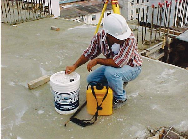
**Figura 10** – Pulverização de produto de cura sobre a superfície da laje.
