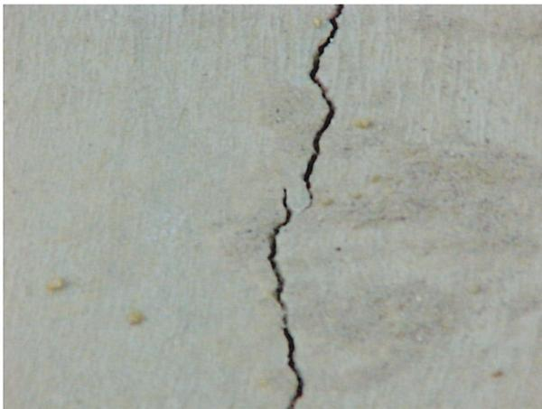
Figura 4 – Fissuras em superfície de concreto devido à retração plástica.
