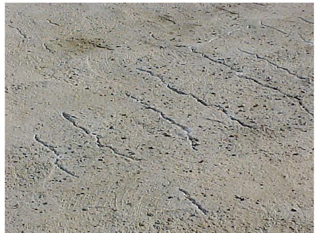
Figura 5 – Aspectos das fissuras por retração plástica.
