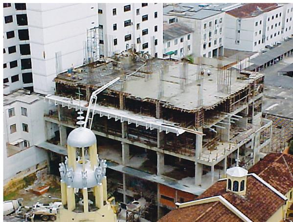
**Figura 2** – Laje plana executada em concreto armado.
