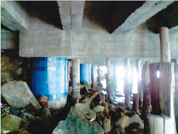
**Figura 27** – Reforço em tecido de E-glass e compósito fibras de carbono.
