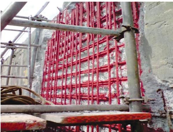
**Figura 23** – Trecho de armadura recomposta.
