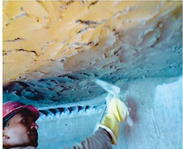
**Figura 24** – Exemplo de recomposição de geometria com argamassa polimérica tixotrópica no fundo da laje.
