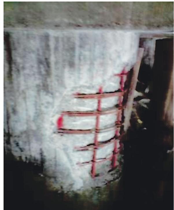
**Figura 25** – Recuperação de armadura do tubulão.
