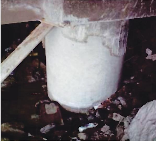
**Figura 26** – Peça com a área recomposta com argamassa polimérica tixotrópica, dispensando-se o uso de formas.
