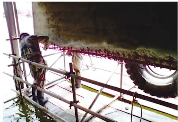
**Figura 21** – Substituição de estribos e delimitação de área com corte com disco diamantado.
