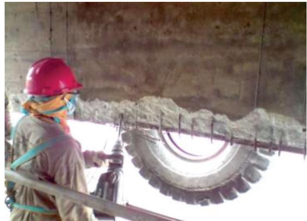
**Figura 20** – Remoção mecânica do concreto disgregado.
