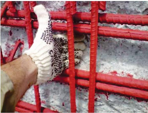
**Figura 22** – Armadura livre do concreto desgregado tratada com inibidor de corrosão.
