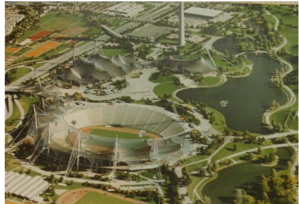
**Figura 8** – Rede de cabos suportada por mastros centrais e cabos de borda, Estádio Olímpico de Munich, Alemanha.
