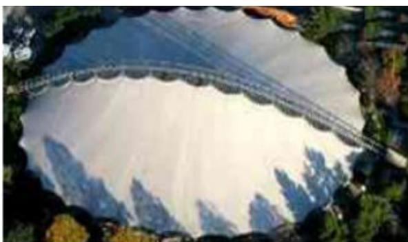
**Figura 9** – Rede de cabos suportada por arco, ring de patinação no gelo, Munich, Alemanha.
