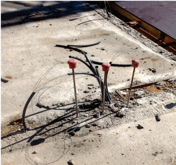
**Figura 3** – Esperas de armaduras e instalações elétricas.
