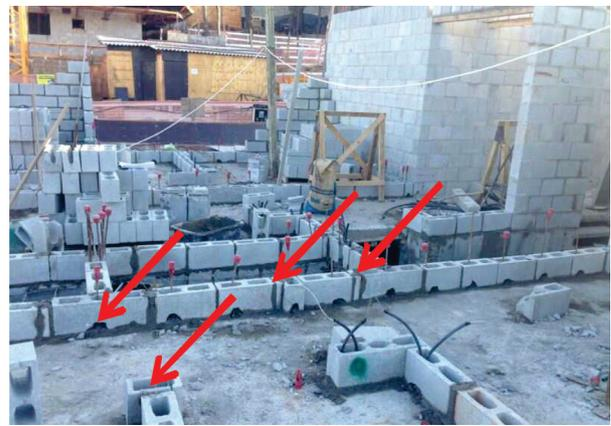
**Figura 4** – Marcação da 1ª fiada das paredes externas e internas.
