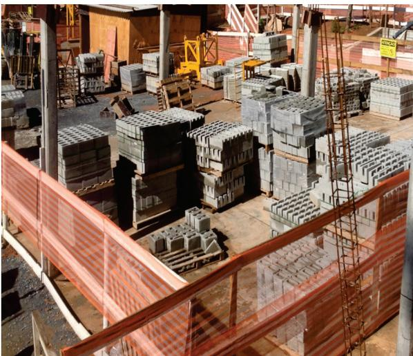
*Figura 1 – Estocagem de blocos em local inapropriado e sem identificação.*
