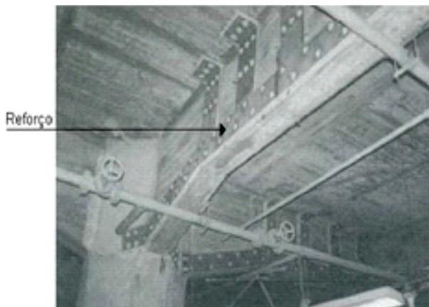
Figura 4 – Reforço com chapas de aço [12].
