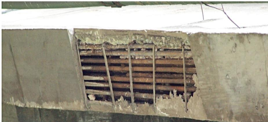
Figura 5 – Armadura exposta na longarina.
