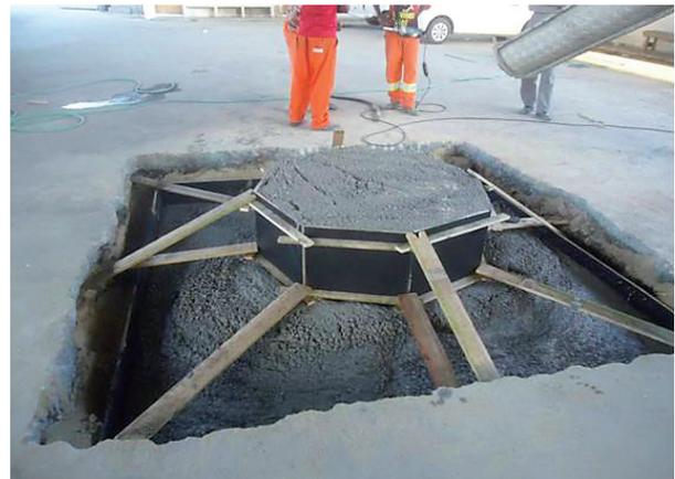
**Figura 7** – Fundação para suporte do aparato de reação.
