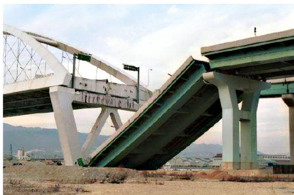
*Figura 1 – Falha em apoio de ponte.*
