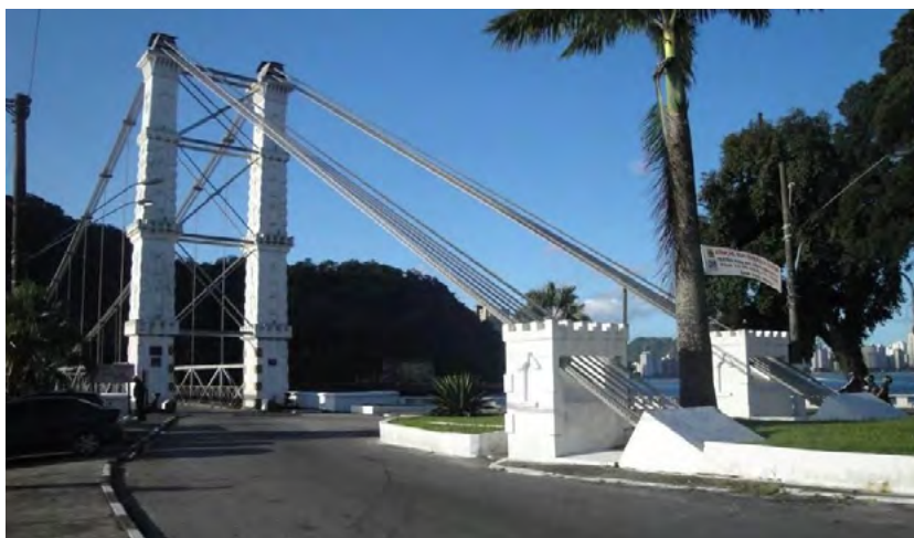
Figura 5 – Vista dos blocos de ancoragem – emboque Praia Grande.
