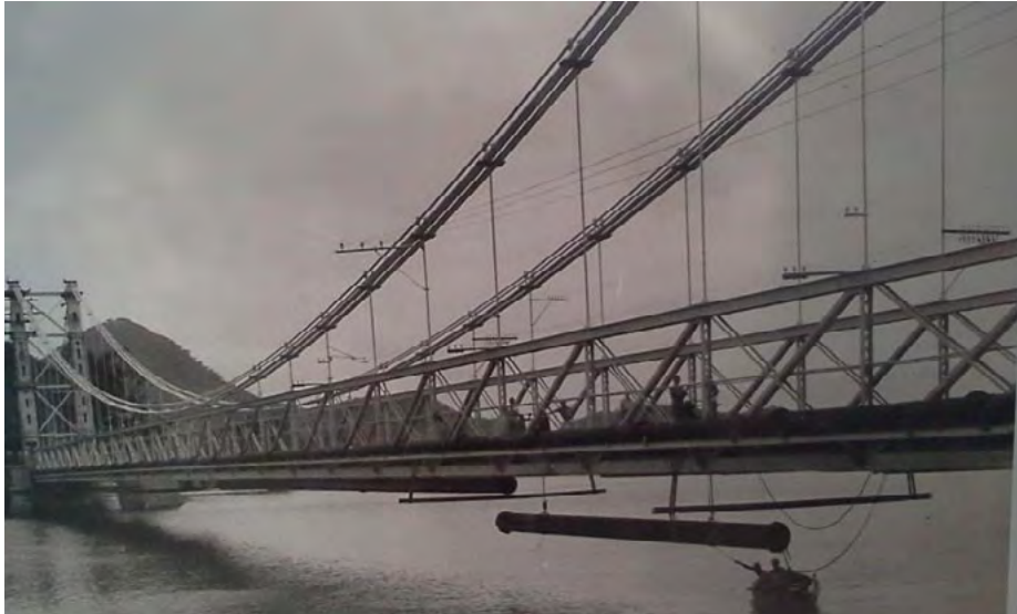
Figura 2 – Perfil longitudinal da Ponte Pênsil em construção.
