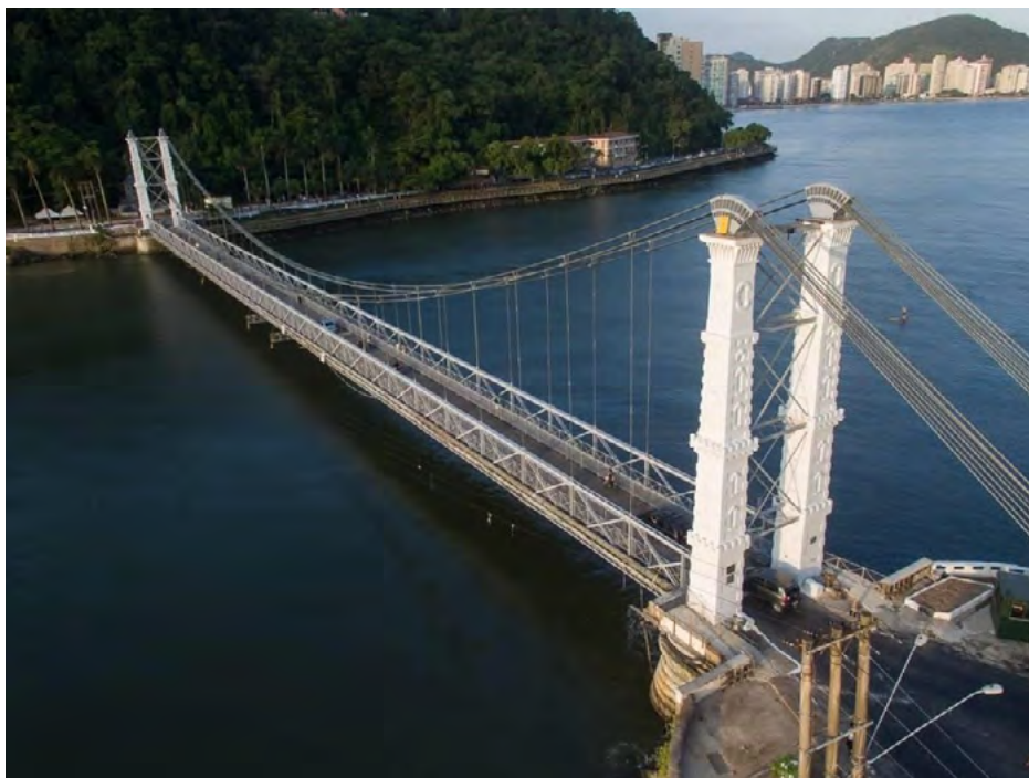
Figura 11 – Vista superior a ponte reaberta ao público.
