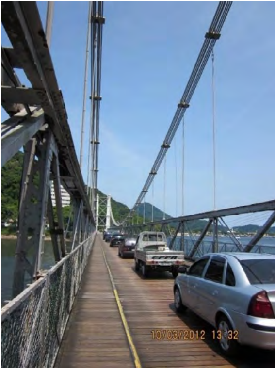
Figura 4 – Vista da seção transversal atual da ponte.
