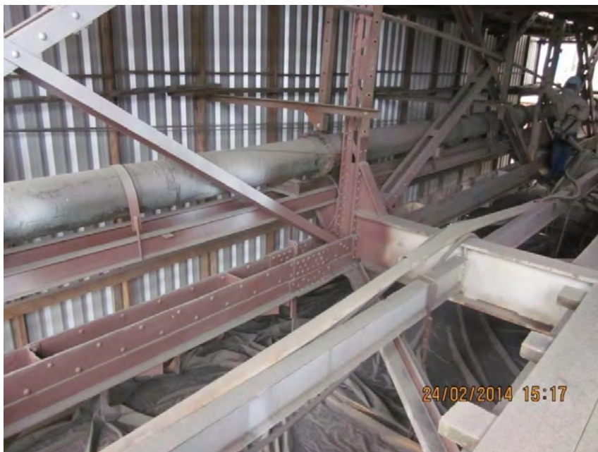
Figura 9 – Tratamento de estrutura metálica do tabuleiro, inclusive com a troca de rebites danificados.
