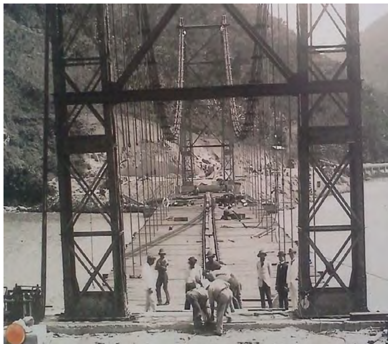
Figura 3 – Vista da Ponte Pênsil em construção a partir do emboque de São Vicente.
