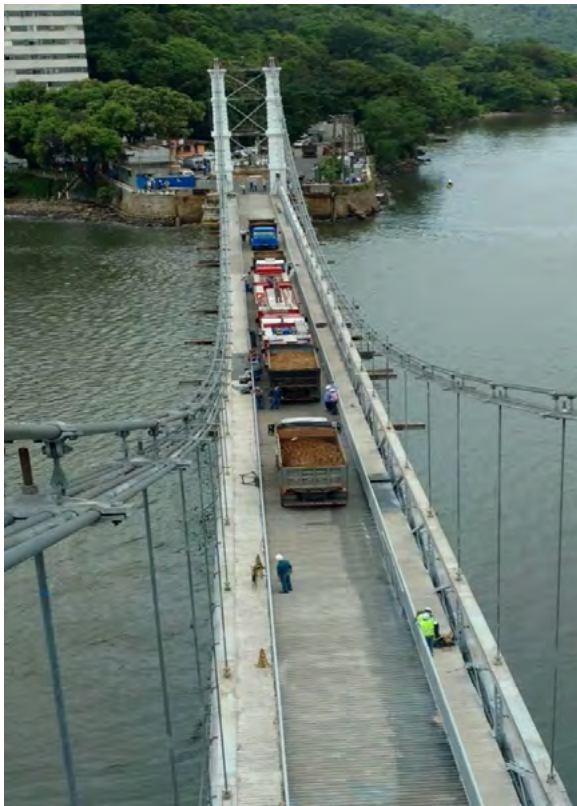
Figura 10 – Vista superior da prova de carga realizada.
