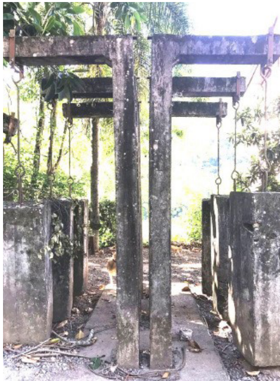
Figura 6 – Vista frontal de medidores de fluência do concreto da Ponte Ernesto Dornelles (AUTORES).
