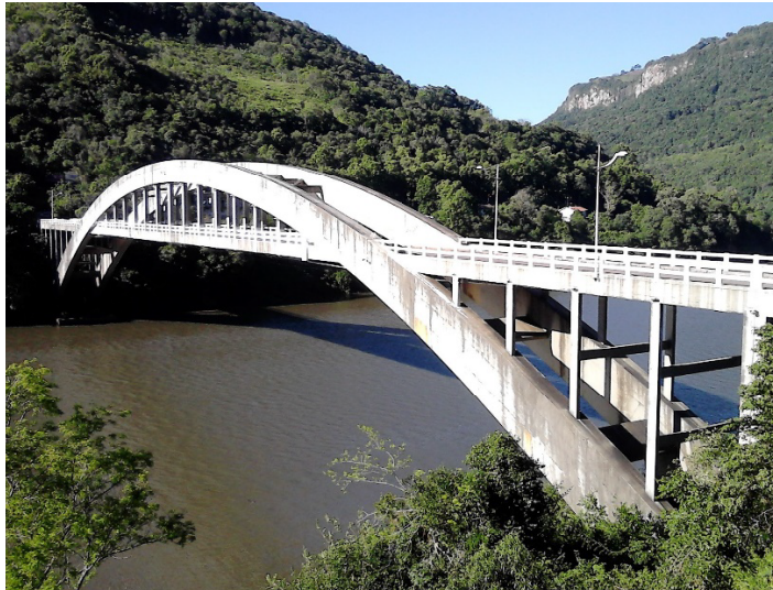
Figura 8 – Vista da ponte Ernesto Dornelles – ponte do Rio das Antas (AUTORES).
