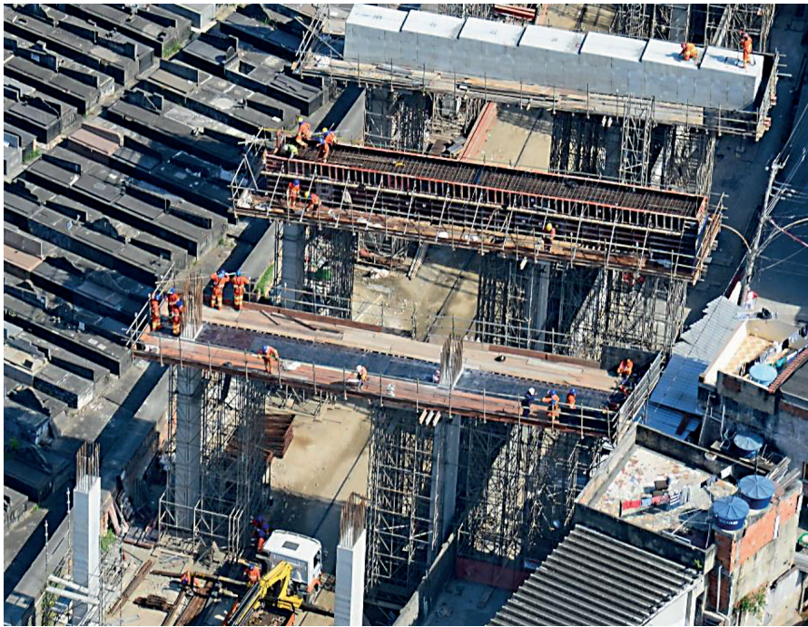
Figura 4 – Pilar estudado durante a construção
