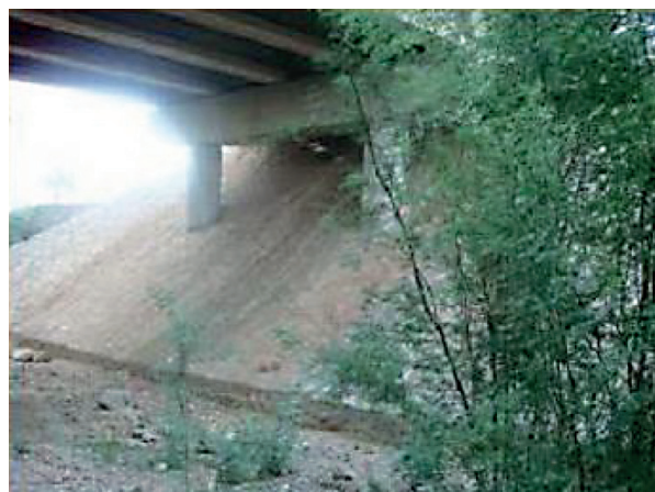
Figura 16 – Taludes dos aterros de acesso revestidos com pedras argamassadas (Fonte: VITÓRIO, 2015).
