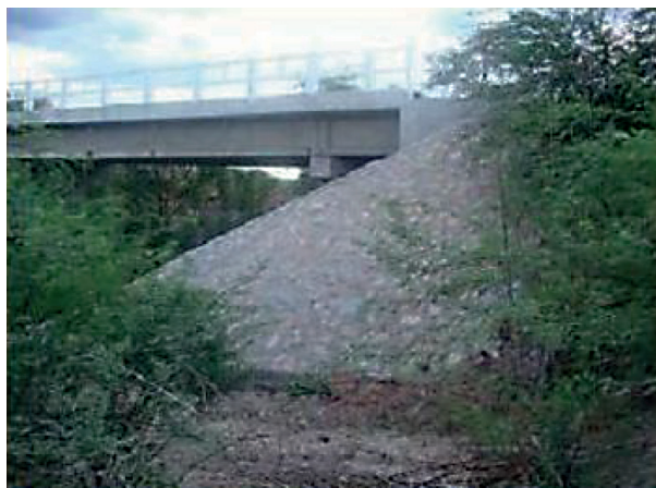
Figura 16 – Taludes dos aterros de acesso revestidos com pedras argamassadas (Fonte: VITÓRIO, 2015).
